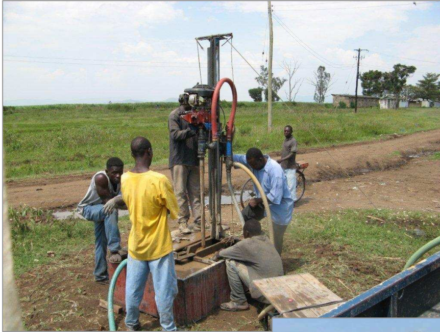
Bohren des Brunnens
